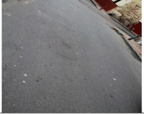
CIV 17000216 - Desgaste lateral costado sur - Fisuras transversales placa 2-97
