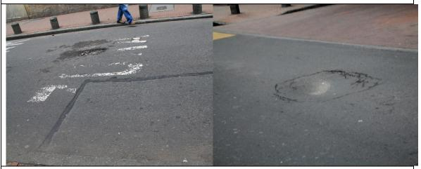
CIV 17000162 - Hundimiento Placa 11-51 y Desgaste prematuro placa 11-67
